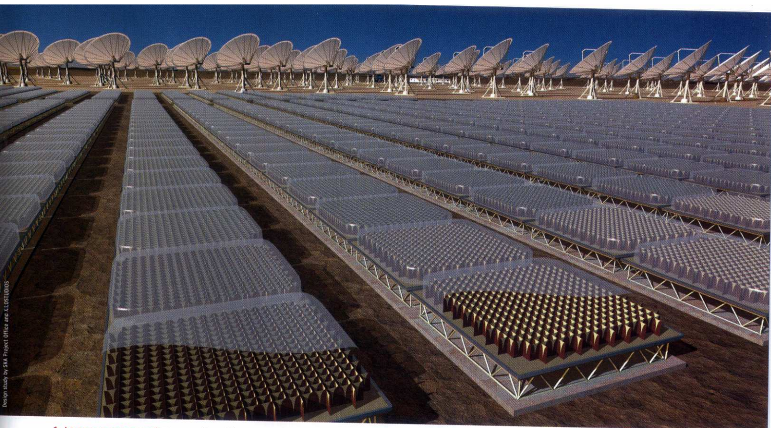
1. LE PROJET DE RADIOTÉLESCOPE géant dénommé Square kilometre Array (SKA) se composera de milliers d'antennes radio (au premier plan), d'une centaine de télescopes paraboliques de taille modeste (arrière-
